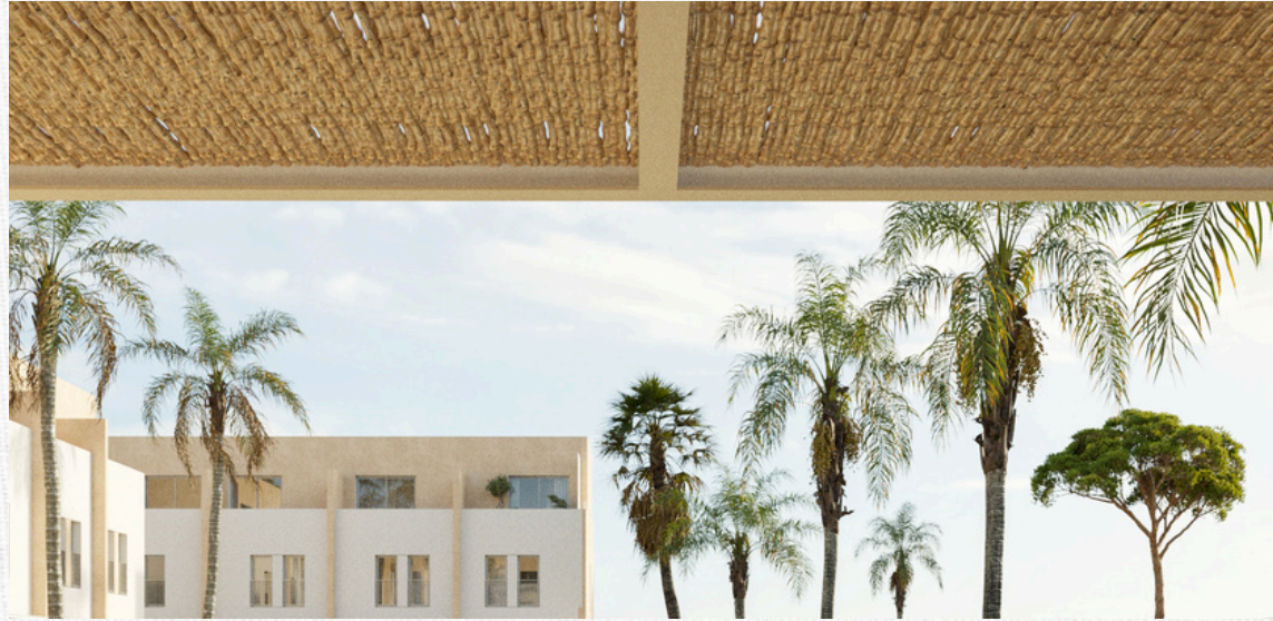
Pérgola metálica cubierta de cañizo
